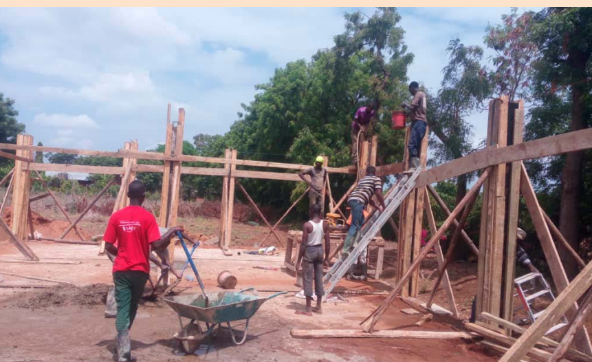
Betonieren des Bodens und Einkleiden der Säulen
