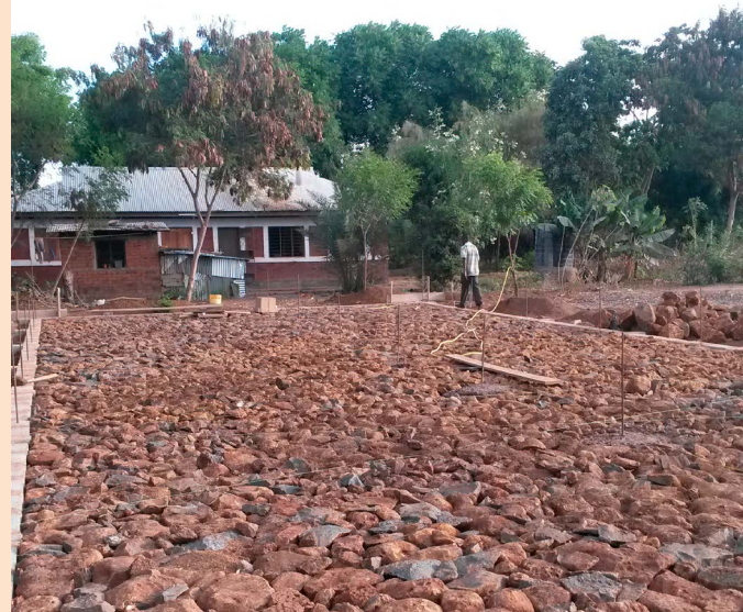
Der Untergrund ist bereits vorbereitet für das Betonieren.
