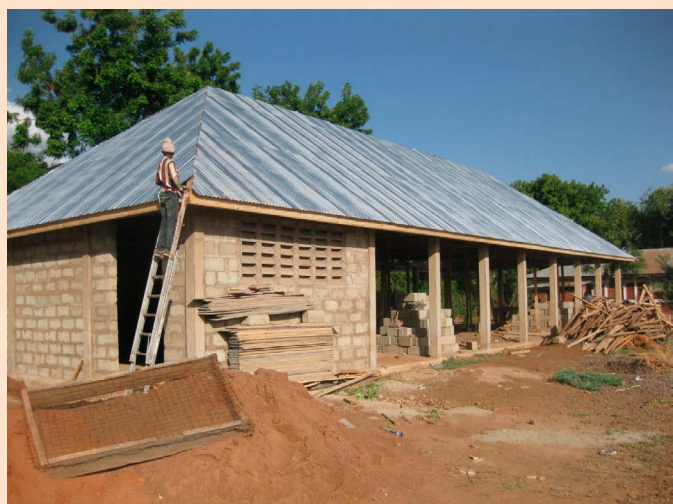
Arbeiten am Blechdach
