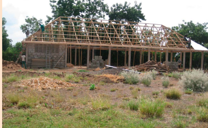
Die Dachbalken sind schon befestigt.
