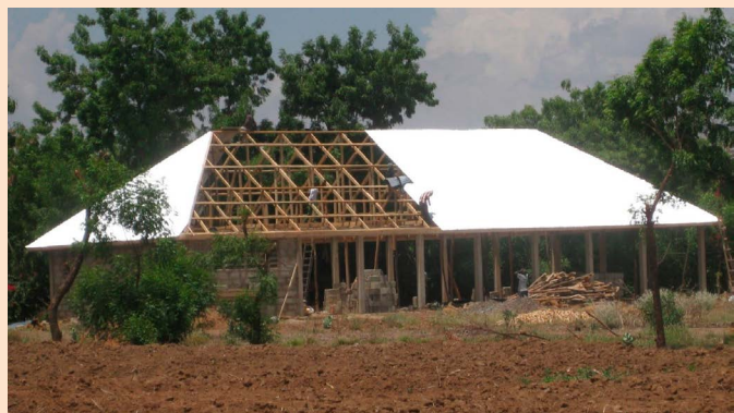
Arbeiten am Blechdach
