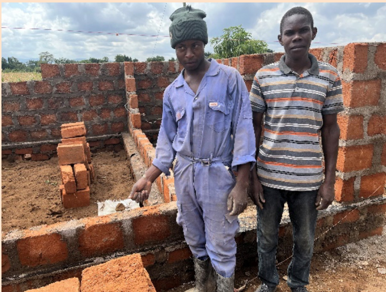
Sunday und Simon (rechts) beim Pflastern
