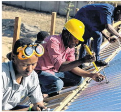
Montage der Solarpanels auf dem Dach. Bilder: zvg
